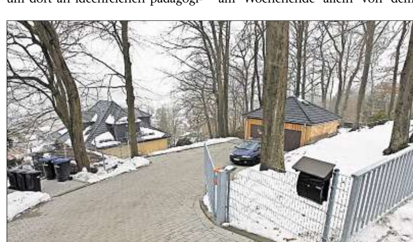
2014 wurde im Außenbereich Geld aus dem Kreishaushalt sowie von der Stadt Zella-Mehlis unter anderem in eine neue Einfahrt und Mauer investiert.
